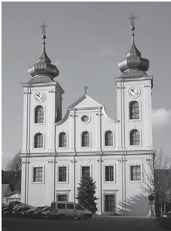
Isusovačka (sada župna) crkva sv. Mihovila u Osijeku (1725.), pročelje (foto: M. Drmić)
