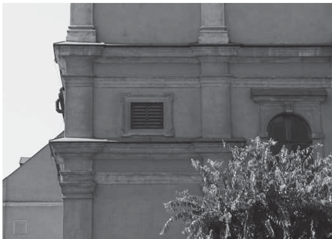
Isusovačka (sada pijaristička) crkva u Trenčínu, detalj pročelja (foto: K. Horvat-Levaj) Jesuit (now Piarist) church at Trenčín, detail of the façade
